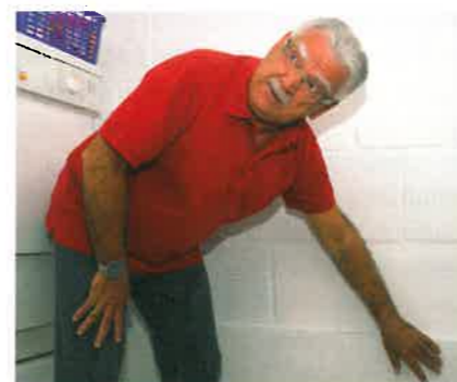
Am Anfang wurden die Feuchtigkeitsschäden im Keller einfach überstrichen – ohne Erfolg.
